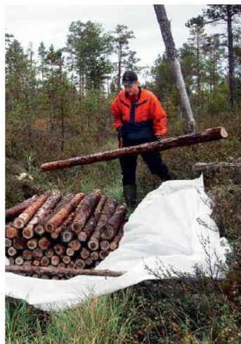
Manuellt dämme under bygget och ett färdigt dämme. Ransi, Dalarna. Om proppen "läcker" i botten kan man trycka ner enbart mer markväv som tätningsmedel och ovanpå detta även försöka fylla på med ytterligare torv om möjligt. Foto: Kurt Rosta
