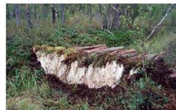
Manuellt dämme under bygget och ett färdigt dämme. Ransi, Dalarna. Om proppen "läcker" i botten kan man trycka ner enbart mer markväv som tätningsmedel och ovanpå detta även försöka fylla på med ytterligare torv om möjligt. Foto: Kurt Rosta
